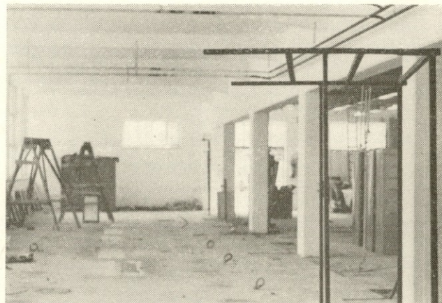
Takole pa izgleda Sulzer od blizu. V ozadju opravlja delavec še zadnja dela na klimatski napravi
