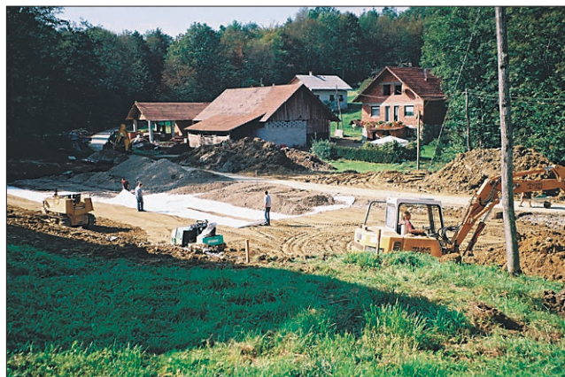
Dela na novem parkirišču še potekajo. Foto: FI
