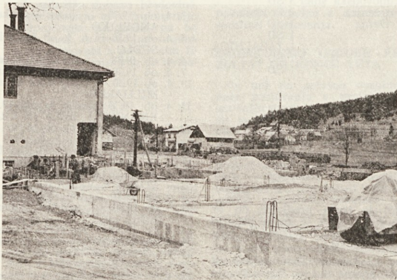
Temelji za novo šolo v Novi vasi
