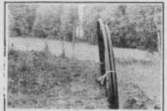
Vodovodne cevi so do bodočih porabnikov vode že speljane, pentlja, ki gleda iz zemlje, pa čaka na povezavo z vodovodnim sistemom
