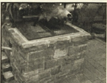
35 Vodnjak na dvorišču hiše v Plenčičevi ulici št. 2
