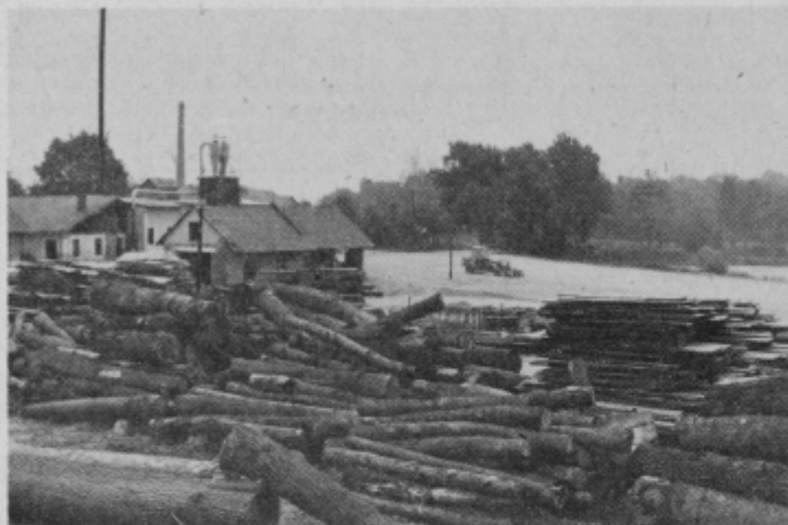
Po rekonstrukciji ormoške žage urejujejo tudi prostor za spravilo lesa.
