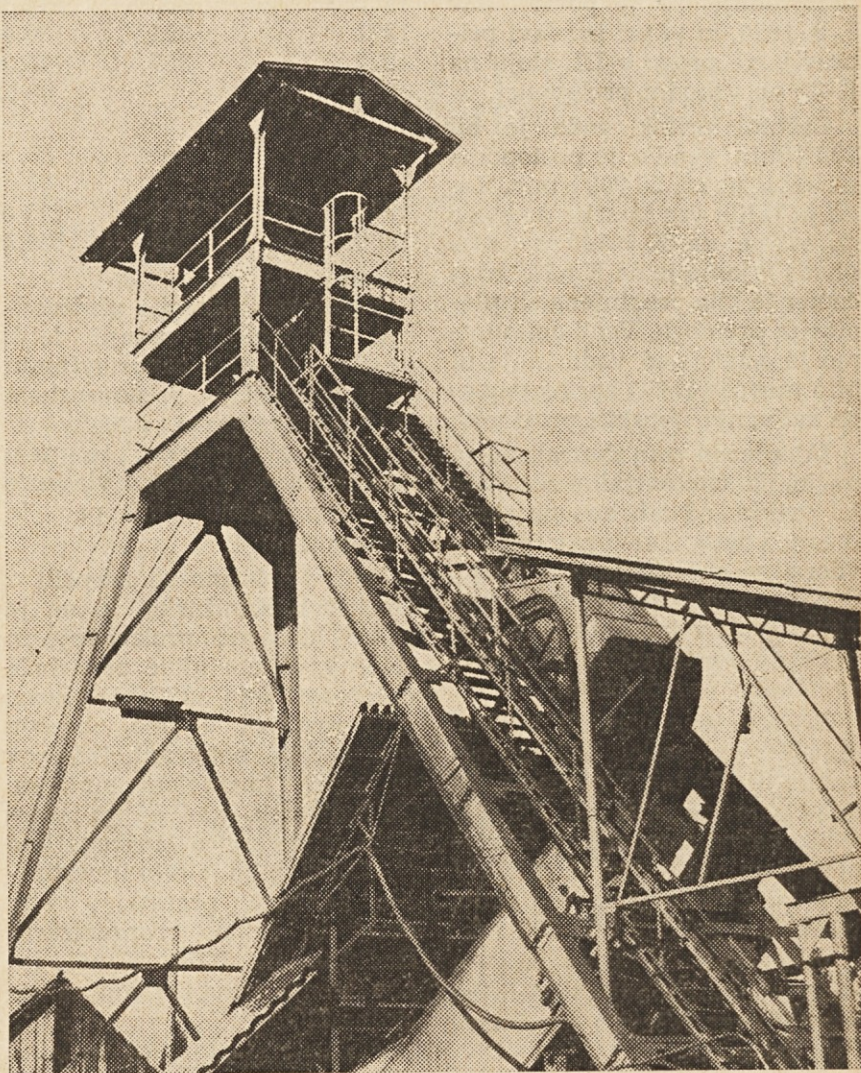
Izvozni jašek v rudniku rjavega premoga Kanižarica.
