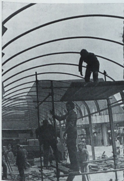
Montaža ogrodja za vezni hodnik
