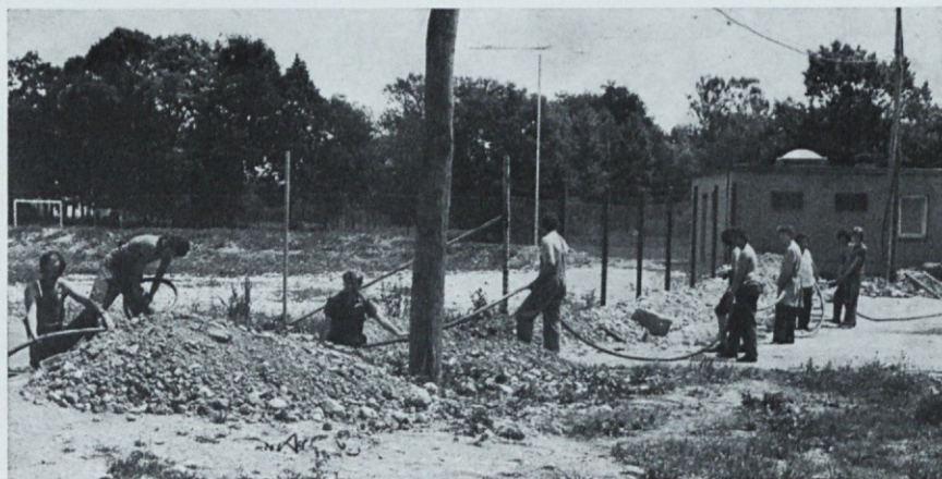
Polagnje električnega kabla za tkalnico
