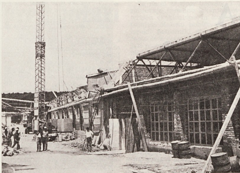
Na sliki je ogrodje novega ostrešja nad novo klejarno v Tovarni pohišstva Cerknica.
