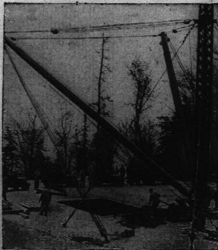
V Fort Lawton, Wash., več milj od obrežja, se učijo pomorščaki kako operirati ladijske škrobo, s katerimi nakladajo in izkladajo na ladjah tovore. Na platformi imajo instaliran škrobec, kakor na ladjah.
