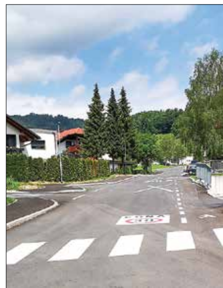
Vse ceste so dobile novo asfaltno prevleko in talne označbe. (Foto: AŠ)
