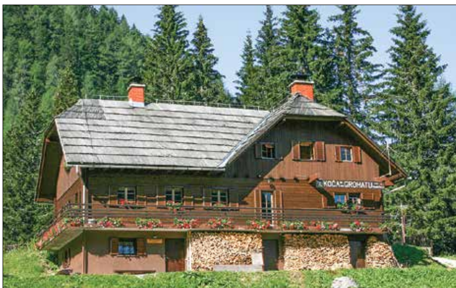
Obnova notranjosti koče je že zaključena, poteka pa še obsežna sanacija zunanosti. (Foto: arhiv PD Mežica)
