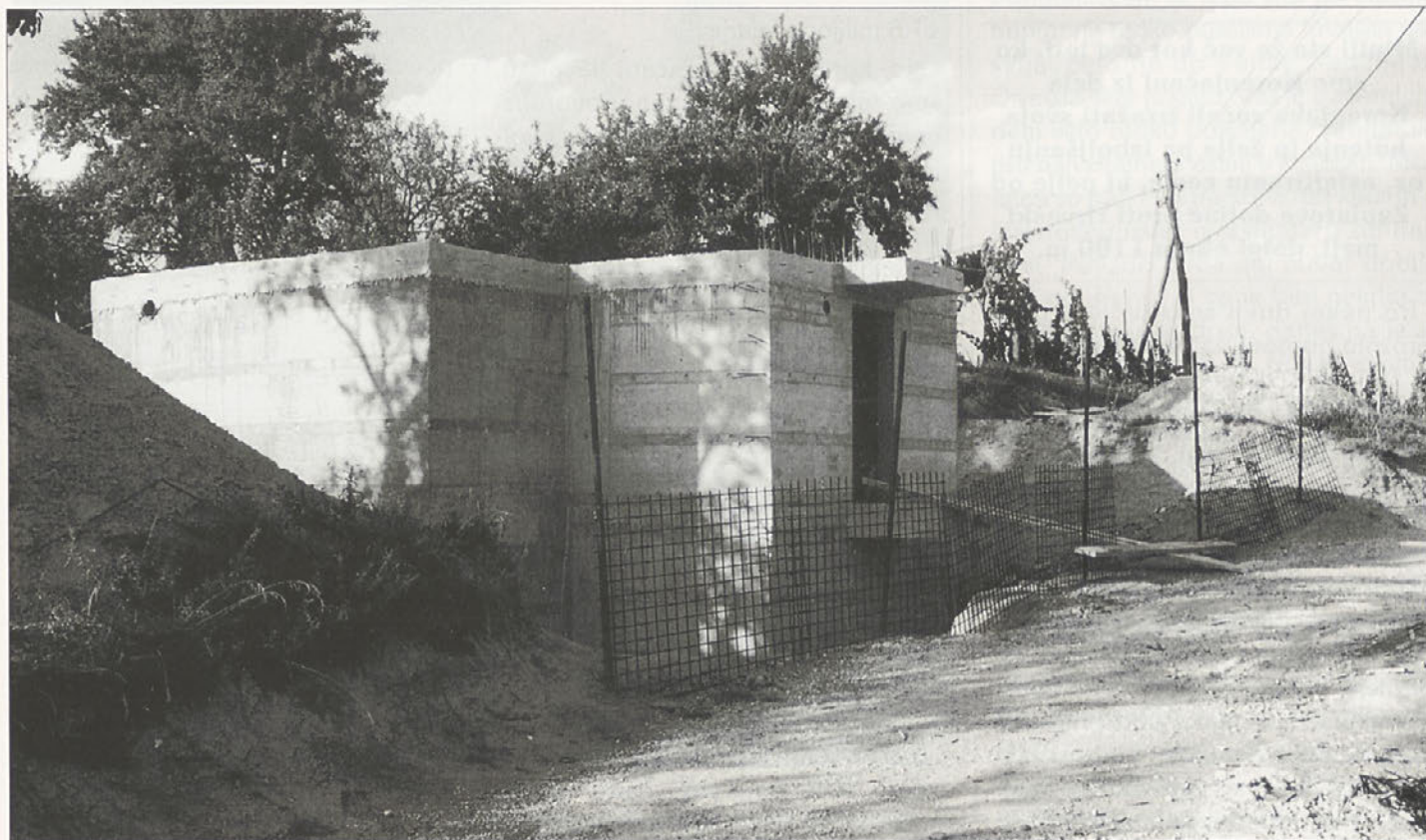
Vodohram v Turškem Vrh je že skoraj dokončan
