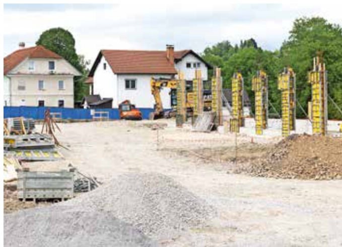
Pred začetkom gradnje je bila izvedena popolna rušitev starega objekta. Na istem mestu bo zgrajen sodoben objekt z novo vizualno podobo in sodobnim konceptom. / Foto: Peter Košenina
