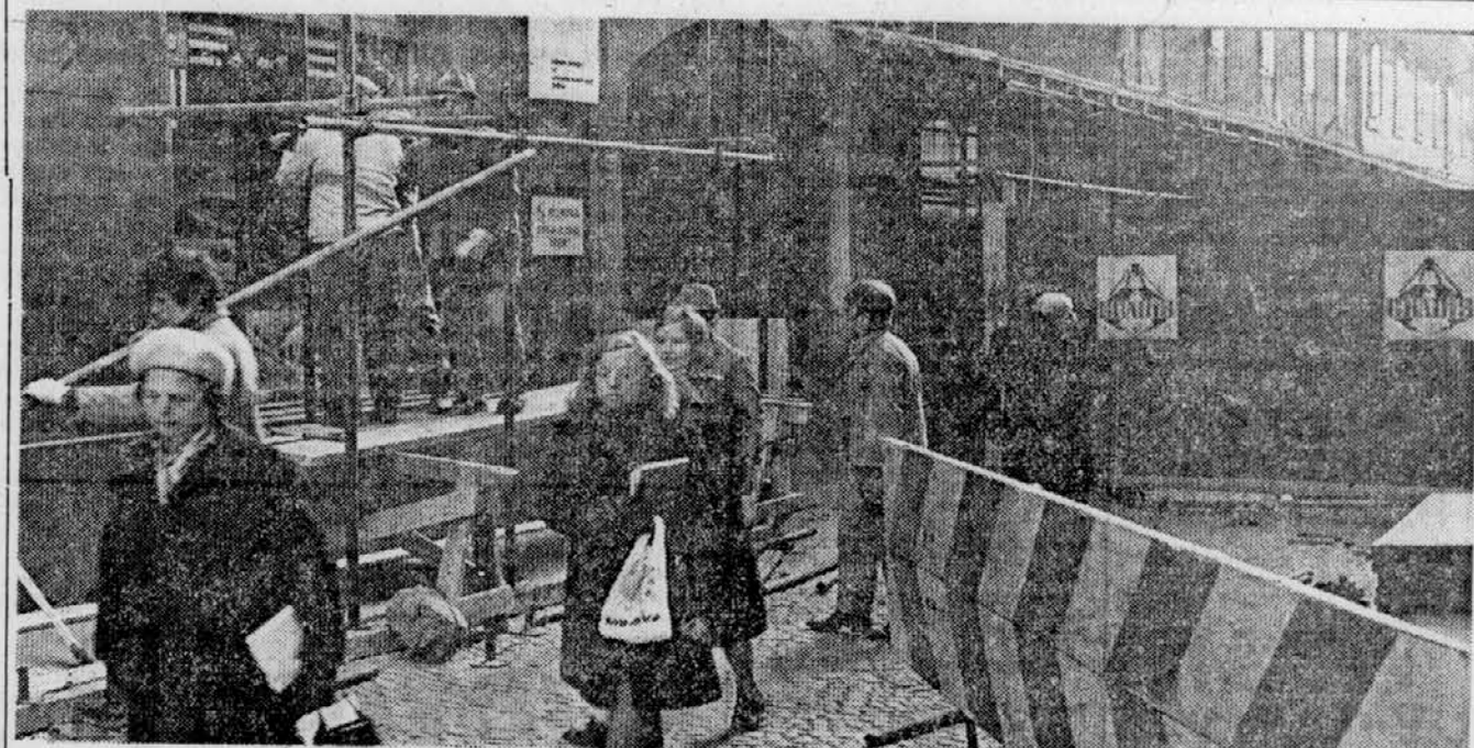
»SLON« BO VEČJI — Delavci »Gradisa« postavljajo zidarske odre ob hotelu Slon v Nazorjevi ulici, kjer bo zato do konca junija letos manj prostora za pešce, pa tudi avtomobili na tem mestu ne bodo mogli več parkirati. Zaradi nadzidave Slona bodo zožili tudi Čopovo ulico, ki bo do srede julija letos ob Slonu za en prometni pas ožja.
