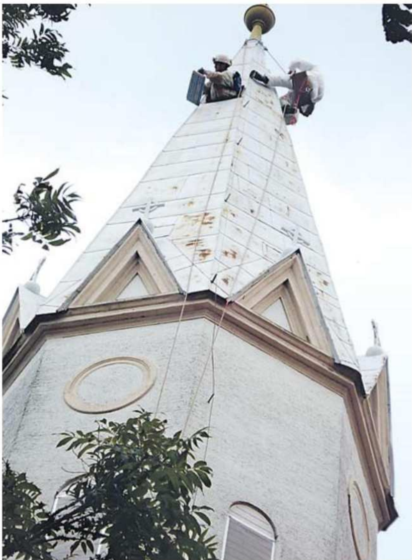
Obnova zvonika je zahtevala pomoč jamarjev.
