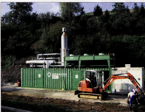
Zaključna dela pri novi mali plinski elektrarni.
