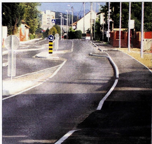
Tako so hitrostno oviro z zamikom osi ceste naredili celjski prometni strokovnjaki.
