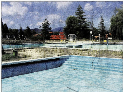
Šoštanski bazen čaka na odstranitev
