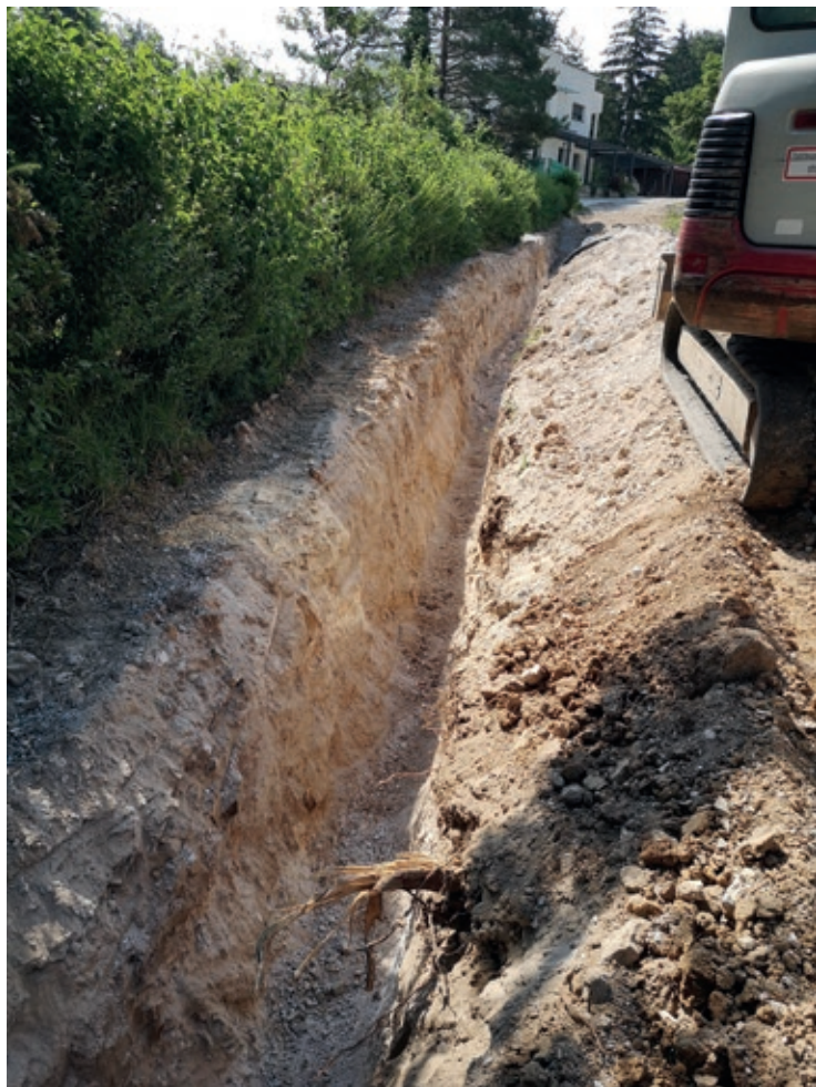
Več kot pol kilometra novega vodovoda v Podgozdu
