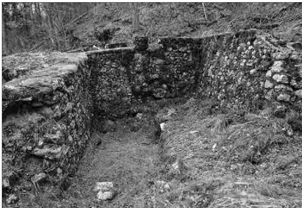
Pogled v prostor B proti vzhodu spomladi leta 2016. V vzhodni steni je vidno, da južni zid prostora D ni bil zgrajen hkrati s to steno, saj na stiku nista gradbeno spojena (foto: V. Pflaum).
