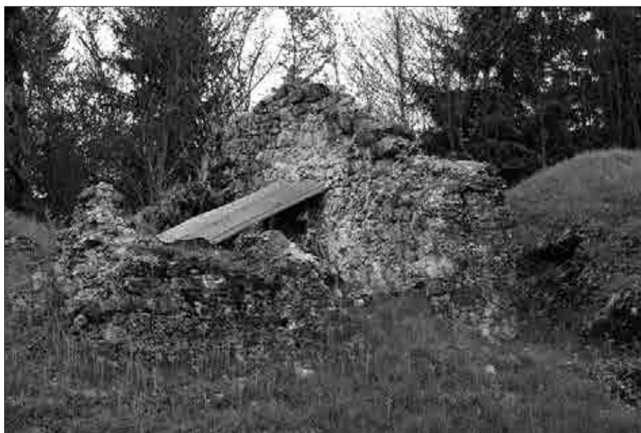
Pogled na ostanke osrednjega dela severozahodnega grajskega trakta z dvoriščne strani (foto: Igor Sapač, maj 2016).
