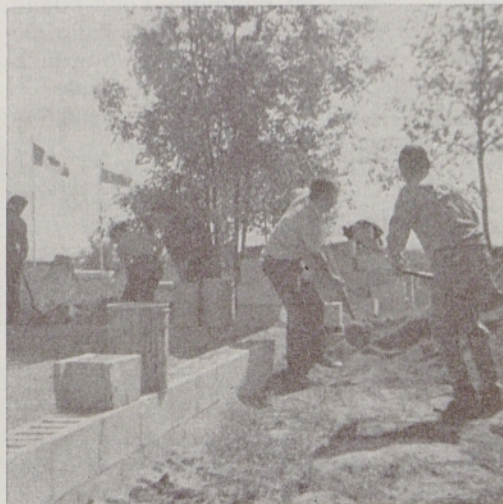
Med graditvijo stavbe na odsekovem zemljišču
