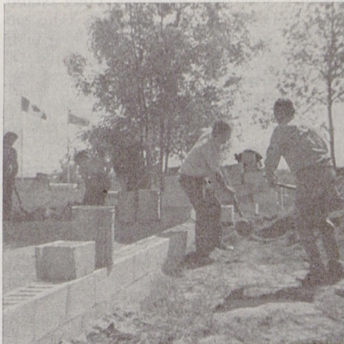
Med graditvijo stavbe na odsekovem zemljišču
