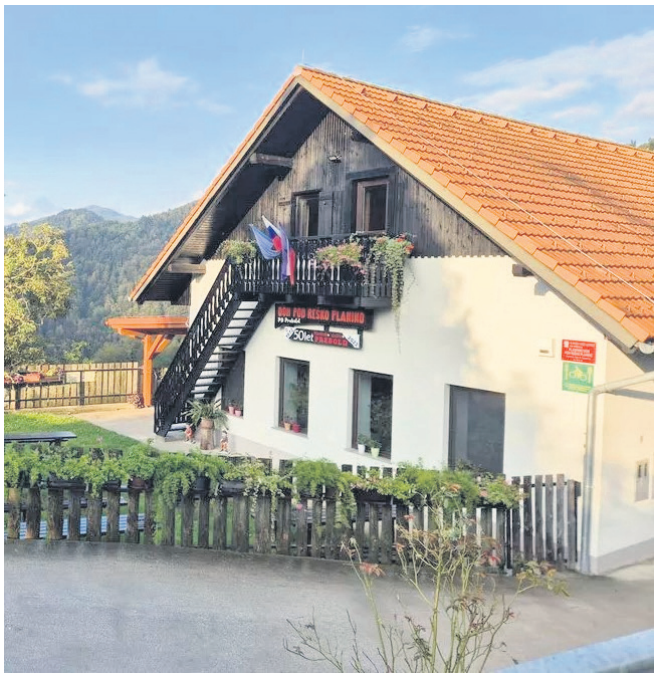
Planinski dom je priključen na električno in telefonsko omrežje, ima lastno vodooskrbo in kanalizacijo. (Foto: Občina Prebold)
