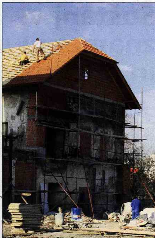
Streho dela stavbe želijo čim prej prekriti in zavarovati.
