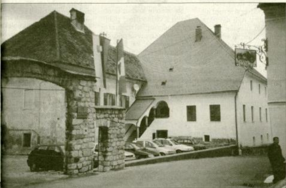
Urejanjem fasade na dvorcu so v Vitanju pohiteli. Zapora ceste iz Vitanja proti Socki zaradi gradnje mostu je bila namreč priložnost, ki je ni kazalo zamuditi, saj je precej olajšala delo gradbincem na sicer zelo omejenem prostoru. Fasada na delu stavbe ob cesti je zdaj končana, most pa tudi že zgrajen in prevozen.
