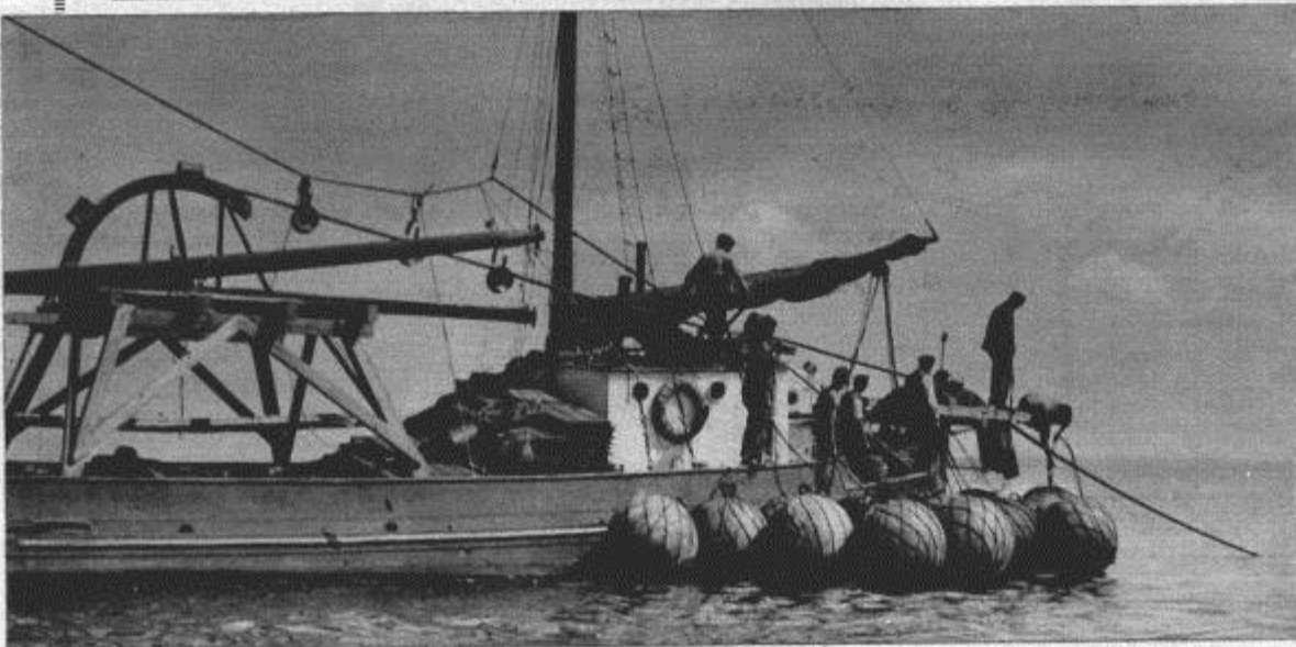
Das Seekabel läuft über die Hedrolle von dem Verlegedampfer hinab ins Meer
