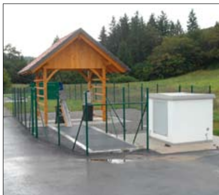
Slika 2: Pogled na celotno območje ČN Zdenska vas
