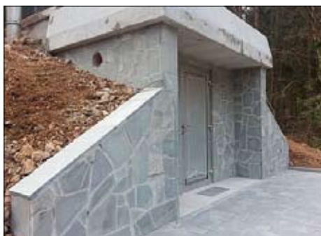
Slika 1: Obnovljeni vodohran na Videmskem hribu
