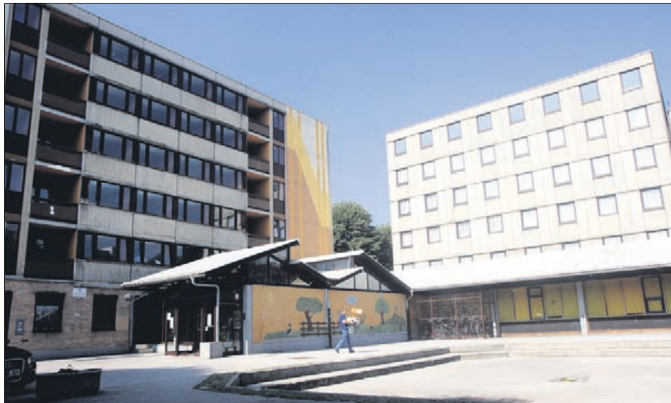
V 80. letih zgrajen objekt je treba temeljito obnoviti. Z deli, vrednimi kar 5,6 milijona evrov, ga bosta ministrstvi za visoko šolstvo in šolstvo uredili v sodoben dom, primeren za bivanje dijakov in študentov.
