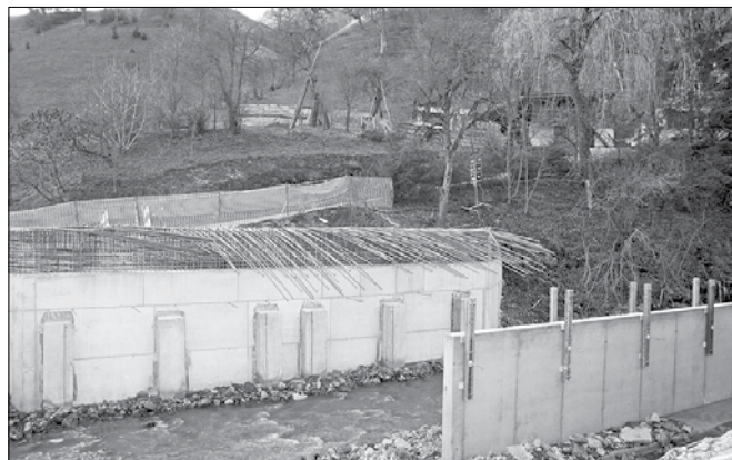
Rok za končanje del na Pažetovem mostu je maj 2014.
