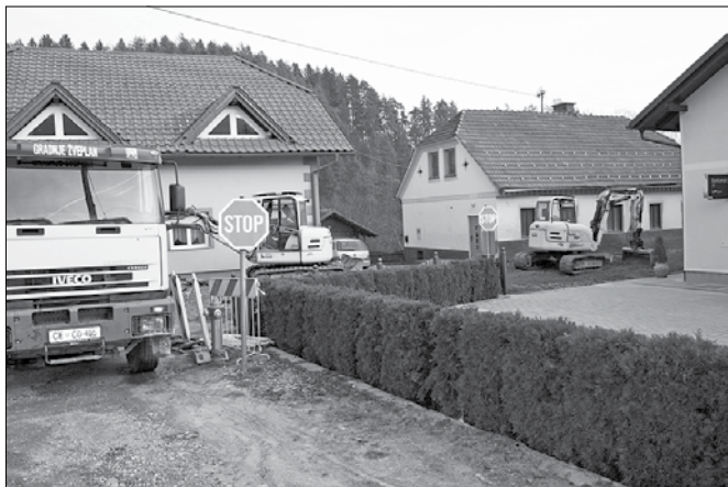
V okviru revitalizacije trškega jedra so izvedli vkop komunalne infrastrukture in urejajo preplastitev ceste z grobim asfaltom.
