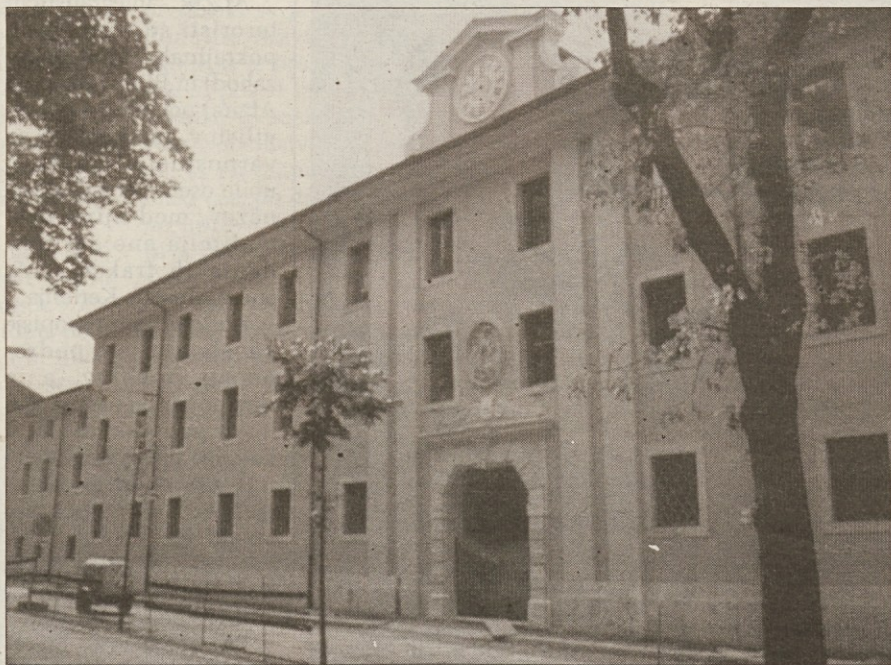
Prenovljeno poslopje nekdanje bolnišnice Usmljenih bratov (foto Bumbaca)
