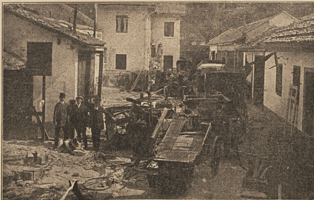
Razrušeni hlevi in dvorišče virilista Jeftanovića v Sarajevu; vse razbito in polomljeno.
