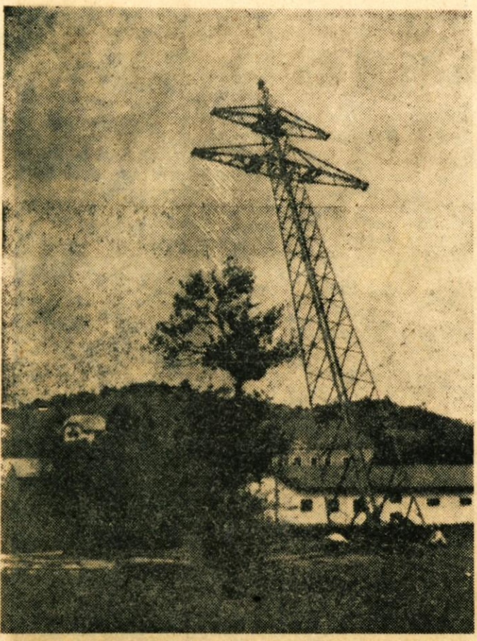
Daljnovid visoke napetosti postavljajo s pomočjo posebnih vrvi
