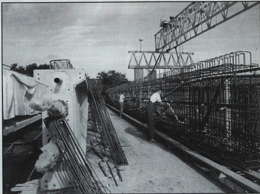
Izdelava betonskih nosilcev na Pobrežju
