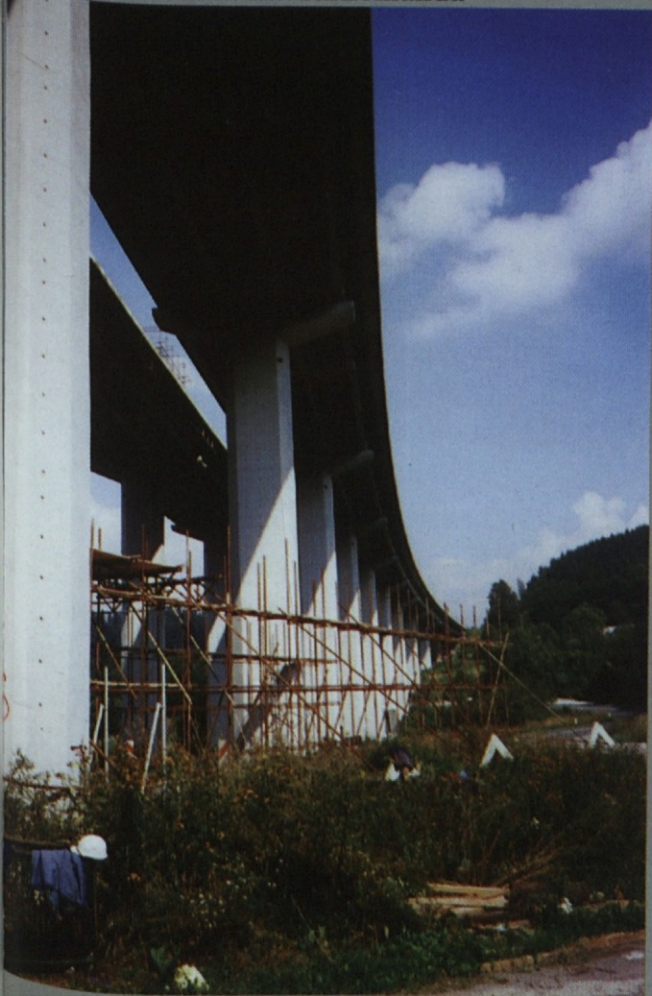
Sanacija viadukta Ravbarkomanda
