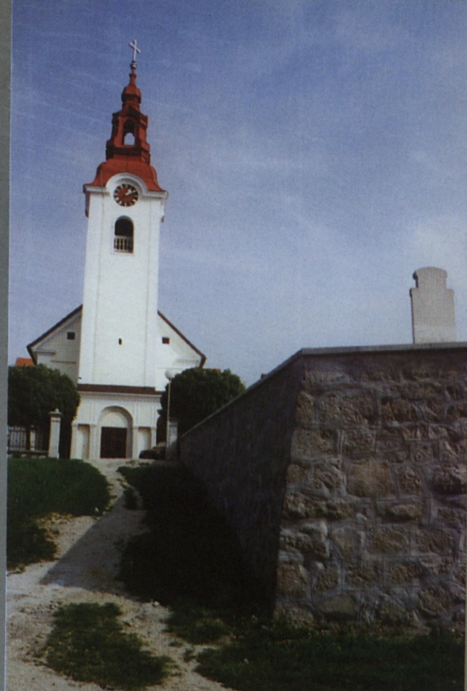
Sanacija pokopališkega zidu v Domžalah
