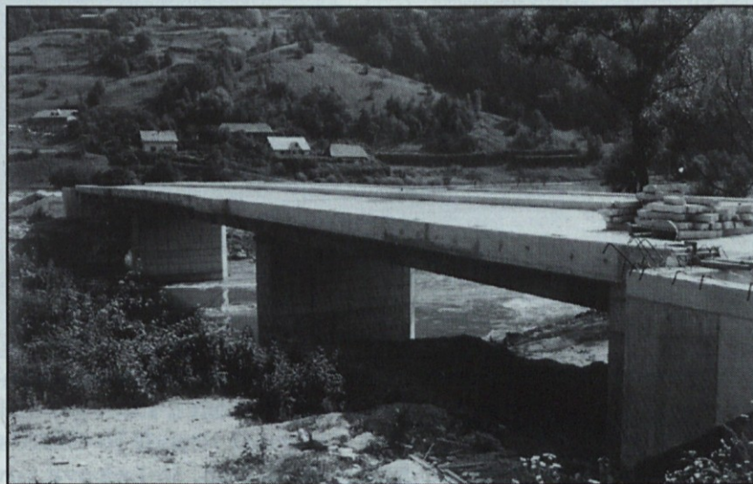
Novi most čez Savinjo v Laškem - delo Gradis, GP Celje
