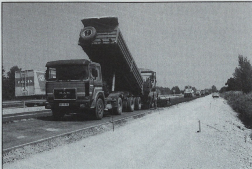
Polaganje asfalta na cementno stabilizacijo na avtocesti pri Framu.
