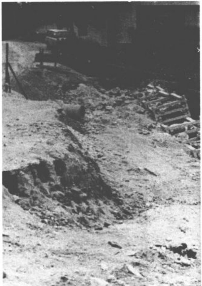
Krajani krajevne skupnosti Podkraj se že precej časa jezijo zaradi plazu, ki je močno uničil cesto skozi njihovo krajevno skupnost. Po maratonskih dogovarjanjih in obljubah sedaj le potekajo sanacijska dela. Upajmo, da bodo končana hitreje kot dogovarjanja.
