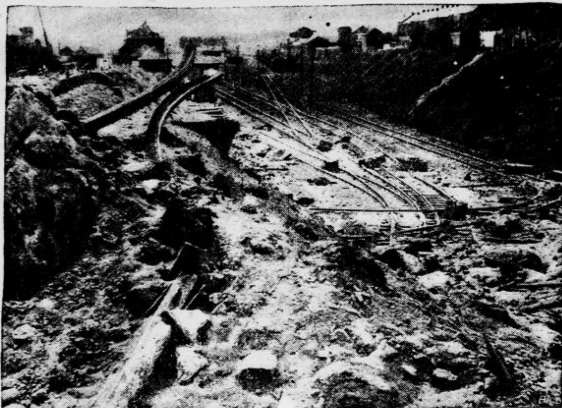
To je posnetek z nekega dela belgijskega bojišča. Železniška proga je tako razdejana, da bo treba mnogo truda in žrtve, preden bo zopet obnovljen promet
