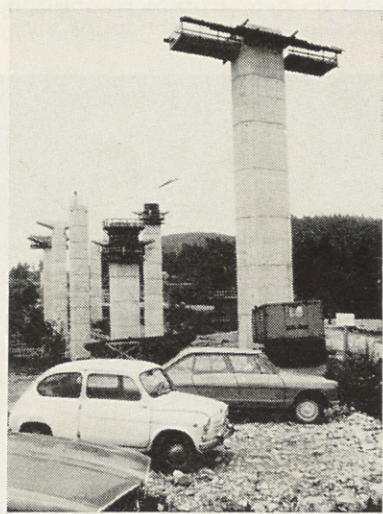
Oporniki za viadukt »Ravberkomanda« na novi avtocesti
