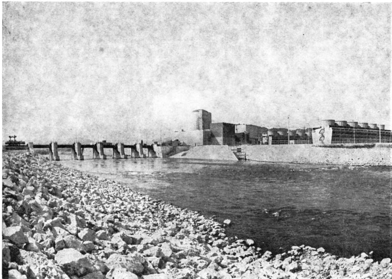
Pogled na Nuklearno elektrarno Krško z desnega brega Save
