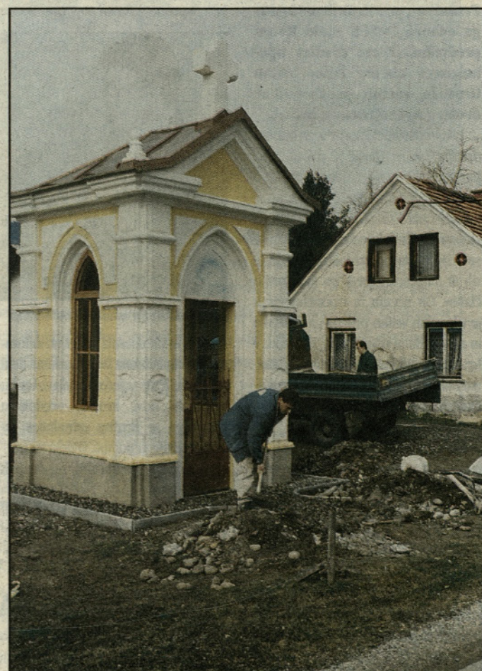
Obnova Štorove kapele v Kamenčah
