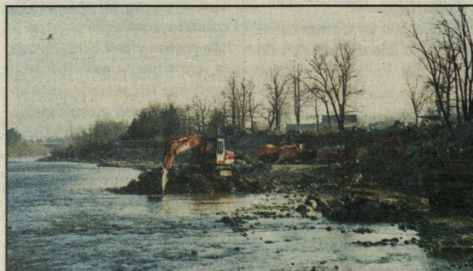
Med gradnjo 400 metrov dolge nabrežine Savinje pri Orli vasi
