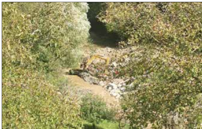
Uničene cevi kanalizacije, ki je tekla pod reko Ljubnico, so zamenjane.
