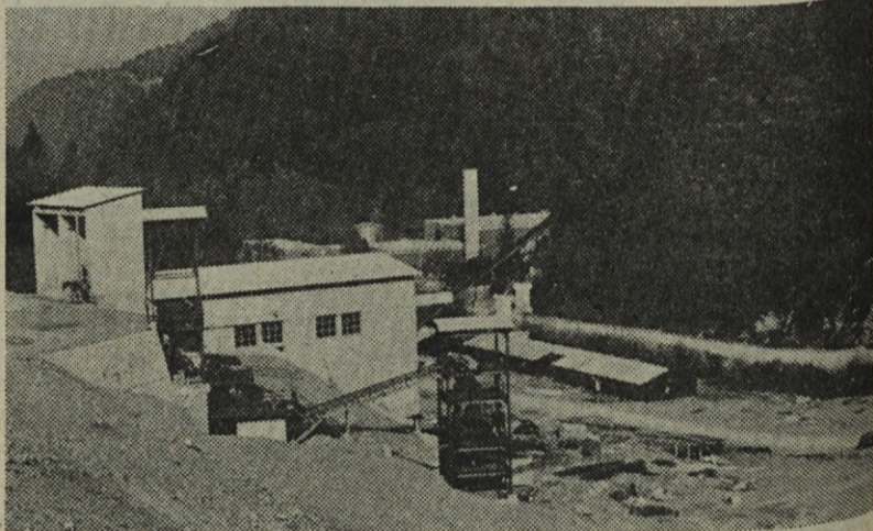
Gradnja Rudnika urana Žirovski vrh gre proti koncu
