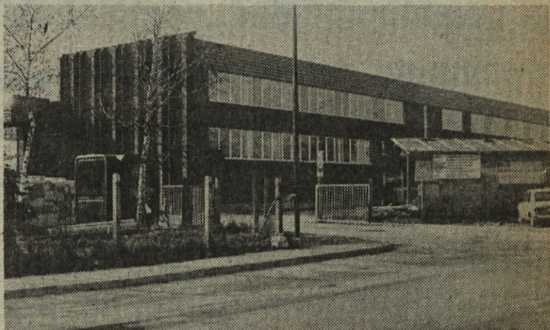
Avtomontažino tovarno grelnih naprav je zgradil TOZD GE Ljubljana
