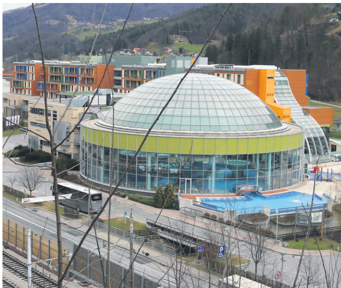
Sončna elektrarna, ki bo postavljena do konca prihodnjega meseca, bo prva tovrstna elektrarna v Sloveniji, nameščena na strehi zdraviliškega hotela. (Foto: SHERPA)
