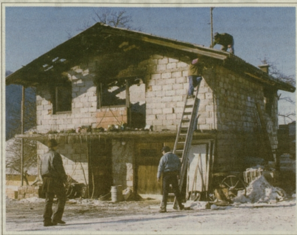
Dom je uničen. Tudi ožgane hišne zidove bo treba podreti.
