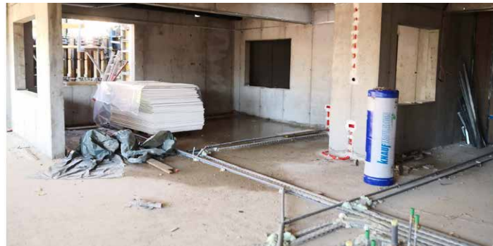
Dnevno-bivalni del, pogled na kuhinjo in TV kotiček v DC Logatec, v fazi gradnje, vir: GANK d.o.o. & Scarpa Studio
