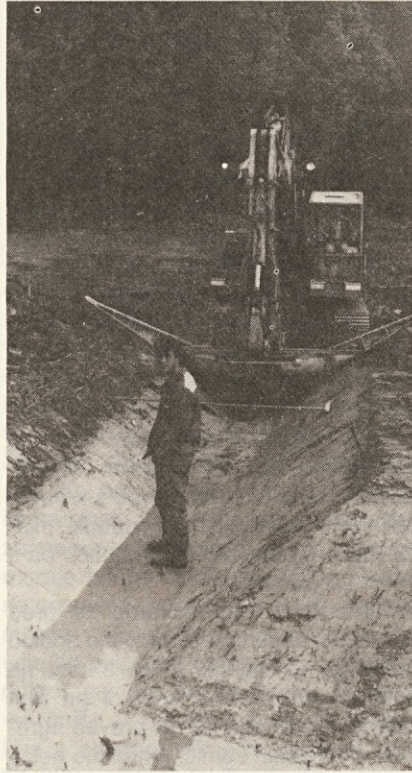
Z melioracijami in komasacijami nastale velike kmetijske površine so prinesle s seboj tudi nevarnost erozije obsežnih območij. Stroj za kopanje melioracijskih jarkov pri delu.
