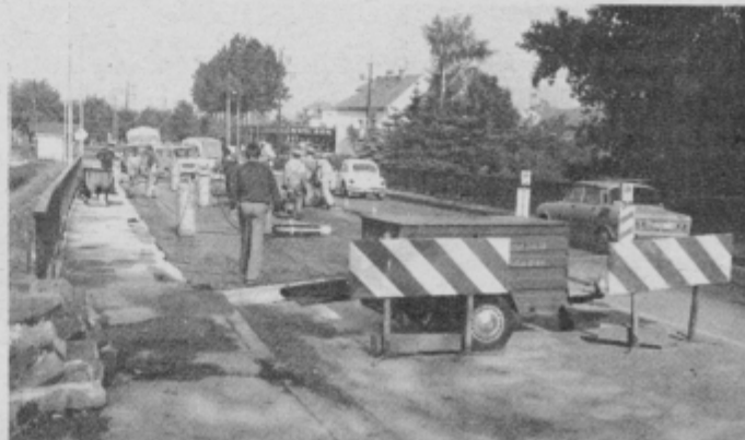
Trenutno potekajo vzdrževalna dela na mostu čez Studenčnico, ki močno ovirajo promet prek dravskega mostu.
