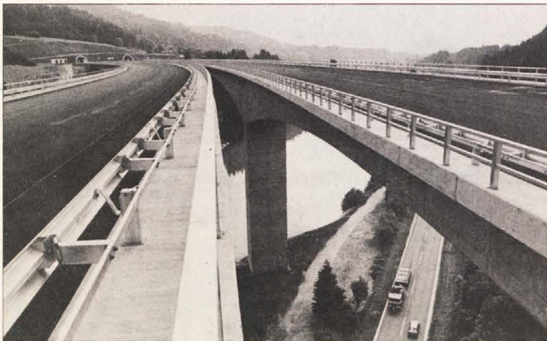
Novo beljaško obvoznico z mostom preko Drave in 4 kilometre dolgim predorom so zgradili v treh letih.
