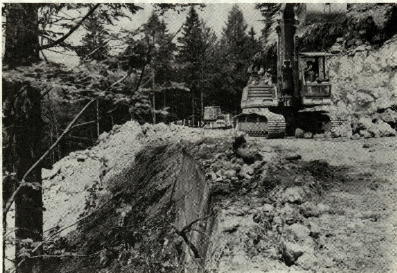
Pri rekonstrukciji ceste na Pokljuko se gradbeniki niso ozirali na gozd. Foto GG
