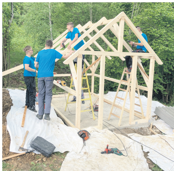
Najprej so na urejeno podlago dijaki Srednje šole za gradbeništvo in varovanje okolja ŠCC namestili leseno konstrukcijo. (Foto: arhiv šole)
