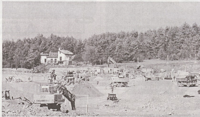
Pogled na gradbišče na mejnem prehodu Jelšane, konec januarja
