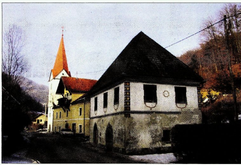
V Lembergu so jo ohranili trški rotovž. Po jesenskem začetku obnove imajo v stavbi, povezani z legendami, prvič priključek na elektriko.
