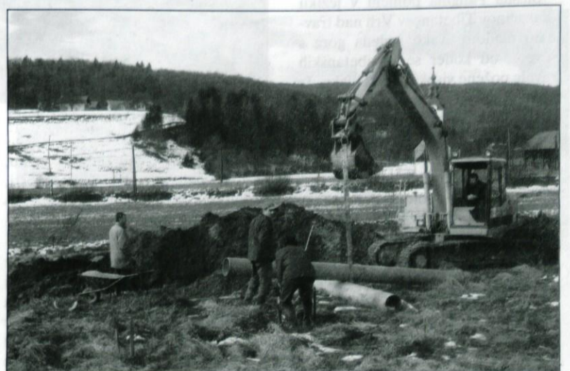
Februarja je izvajalec Komunalne gradnje d.o.o. Grosuplje polagal cevi za primarno kanalizacijo III. gradbene faze Višnja Gora - Ivančna Gorica v Zgornji Dragi.
