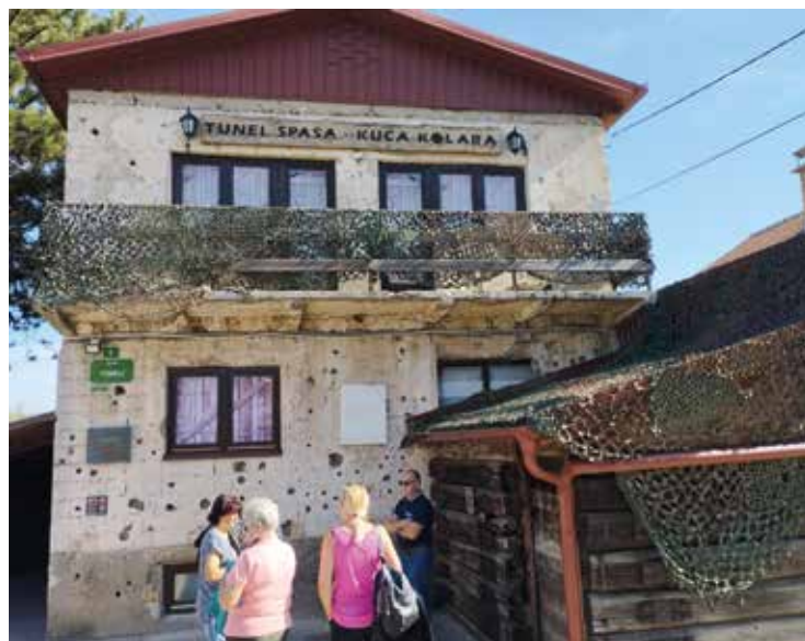
Tunel rešitve blizu Sarajeva
