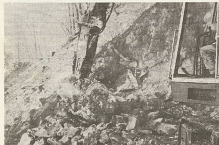
Za hidravlično kladivo skalnati skladi na trasi ceste niso prehuda ovira. (Foto: J. P.)
